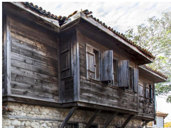
Фиг. 87. Дървена фасадна обшивка от по-новия тип (2023)
