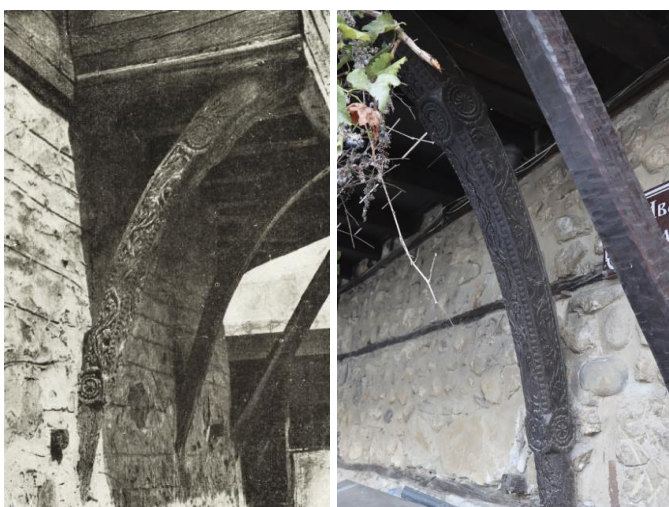
Фиг. 88. Дървен подкос на къщата на В. Ламбринов (диахронен анализ 1957 и 2023). Чертеж на дървен подкос (Иванчев, 1957)
